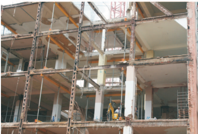
Teilabbrüche von Deckenbereichen - dieser Gebäudeteil (Bauteil 3) bleibt stehen
