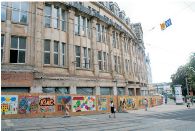
Die Vordächer im Eingangsbereich sind komplett abgerissen.
