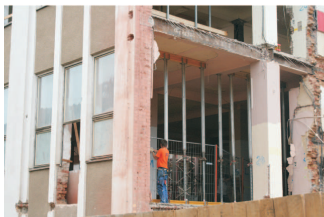
Blick in das verbleibende (Bauteil 3) von der oberen Forststraße aus gesehen
