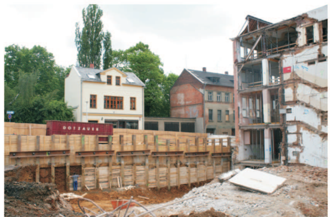
Baugrube für den Neubau (Bauteil 4) Ecke Forststraße/ Rädelsstraße
